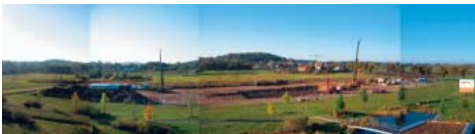
Aushub der Baugrube Anfang Oktober 2004.
